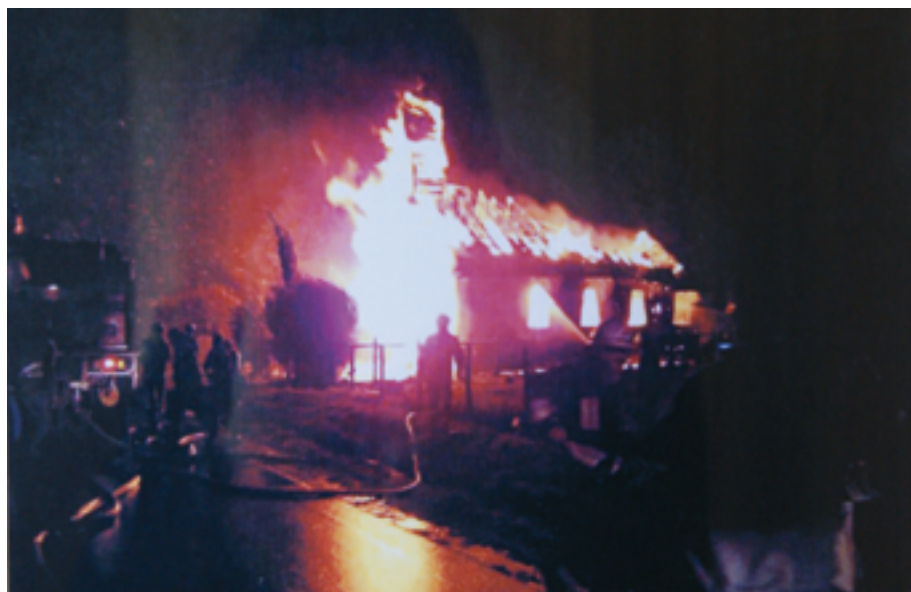
Durch Brandstiftung zerstört – die alte lutherische Kirche in Los Muermos
